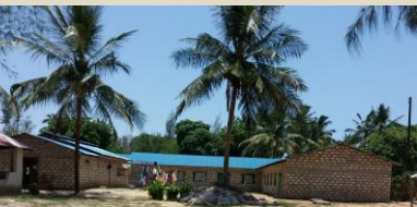
Schlafsaal und Sanitärgebäude
